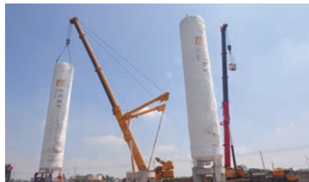
江宁公司投资建设上湖LNG储配站
